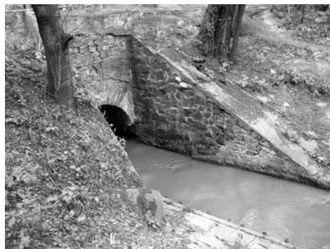
Fot. 5. Potok Bielszowicki zwany Kochłówką – zanieczyszczone ściekami komunalnymi.
