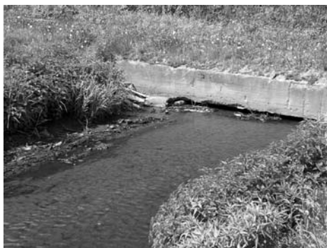
Fot. 7. Potok Czarniawka Zabrze – osady komunalne odłożone na brzegach.
